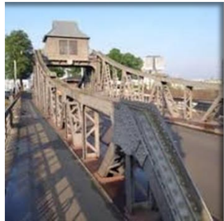
Schwenkbrücke am Deutzer Hafen
